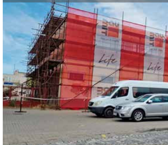
Rekonstrukce budovy Horník s pomocí NRB
