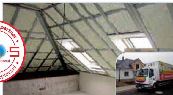
Dokonalé zateplení střechy Čáslav
