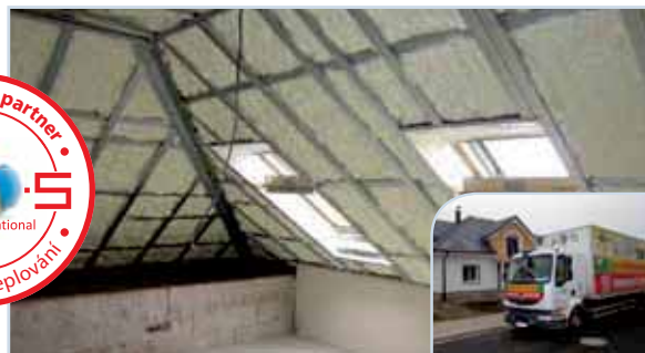
Dokonalé zateplení střechy Čáslav
