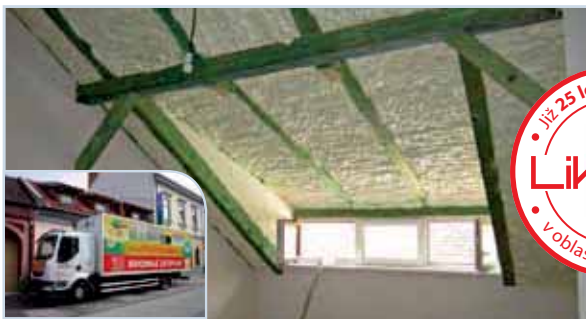
Zateplení všech detailů vikýře a šikminy střechy Rožňava
