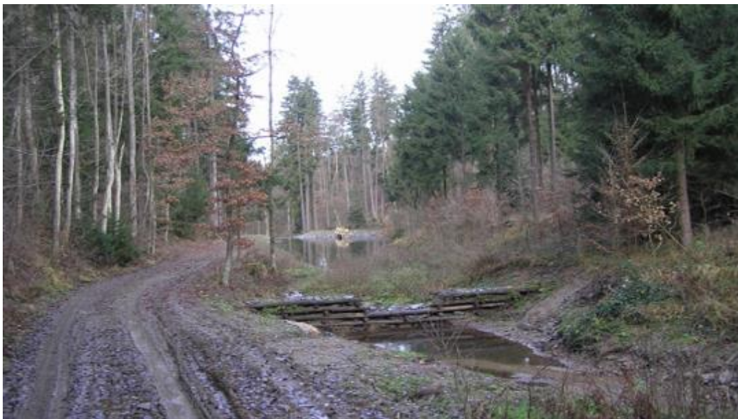
Obr. Příklad podélného zpevnění břehů lesní bystřiny
