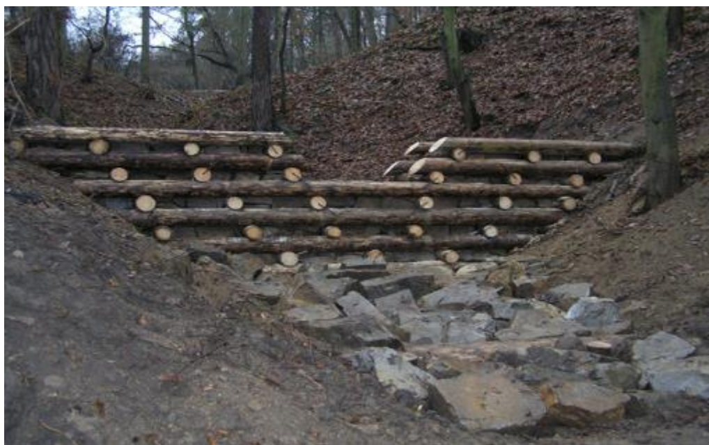
Obr. Ukázka výstavby příčného hrazení bystřin v lesích
