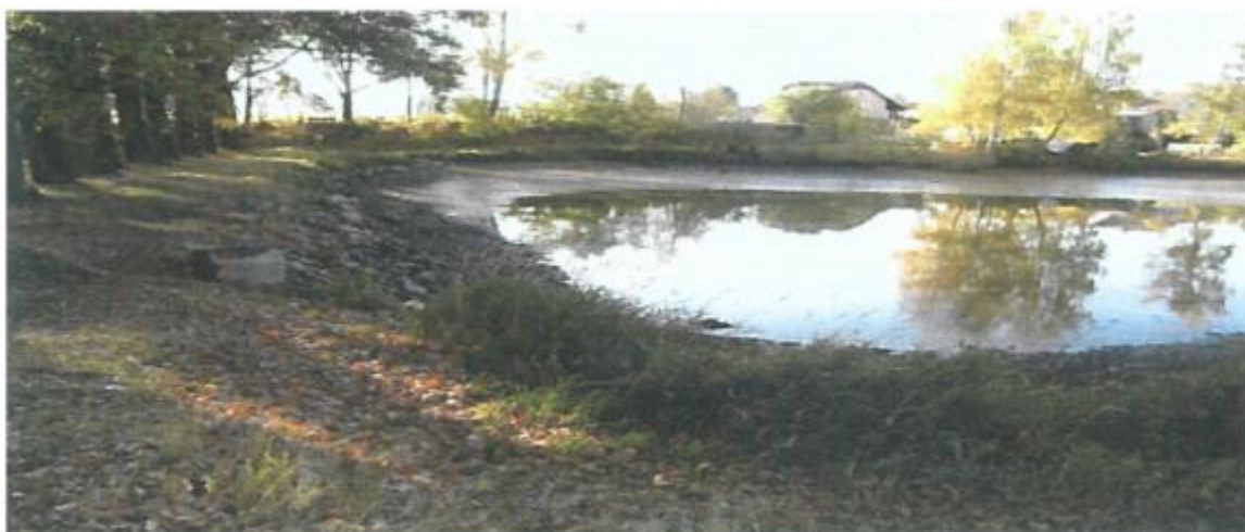
Obr. Stav před realizací
