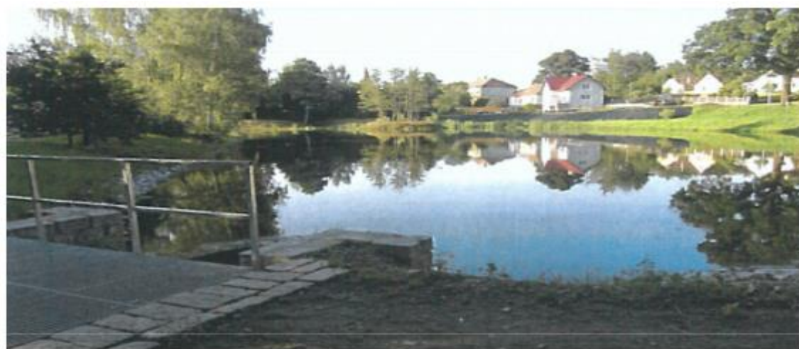
Obr. Stav po realizaci
