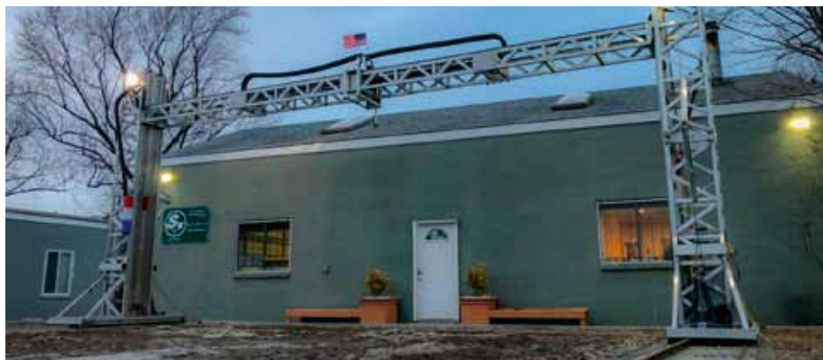
Rodinný dům na začátku roku v USA o ploše téměř 177 metrů čtverečních, postavili tři lidé za osm dní. Samotný tisk přitom trval pouhých 48 hodin. Dům byl vytisknutý na místě stavby a cena materiálu nepřekročila 6000 dolarů, tedy v přepočtu necelých 136 000 korun
