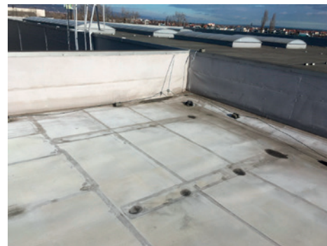
Mechanické kotvenie povlakovej krytiny v nárožnej časti strechy príložnými pásmi.
