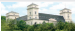
Zámek Račice, přestavba
