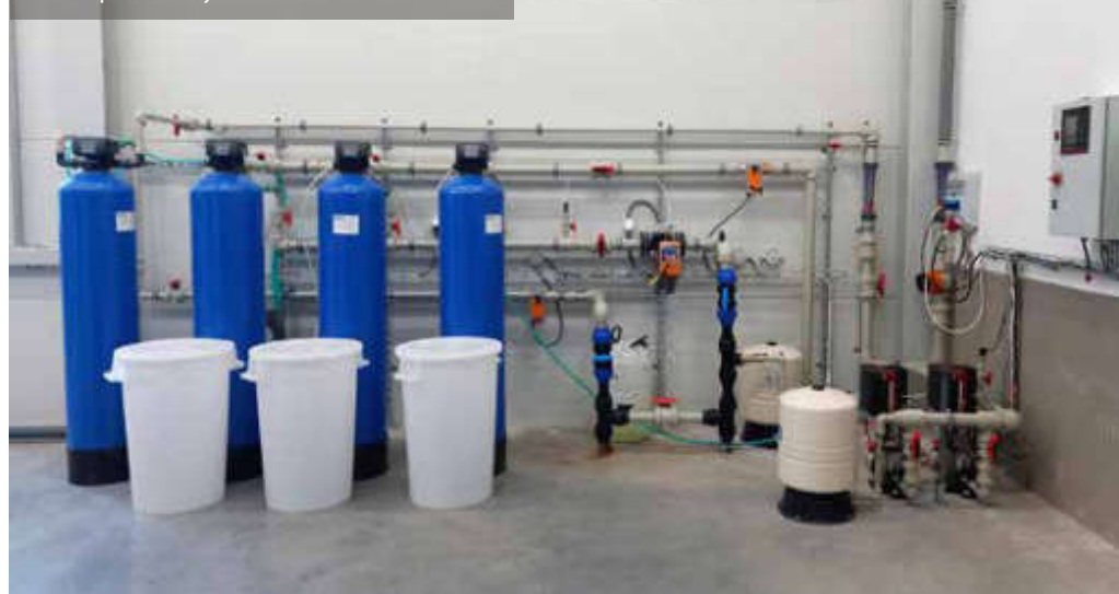
Nová úpravna vody
